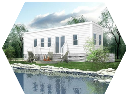
トレーラーハウス
